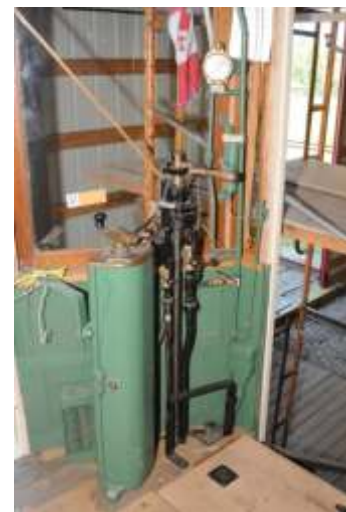
A end vestibule
